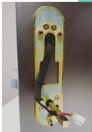
4 Tre deretter på den innvendige gummpakningen og koble ledningen fra ytterdelen inn på innvendig del. Det er kun en måte å koble ledningen til innvendig del.
